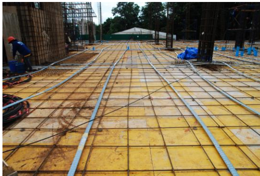
๔) ติดตั้งจัดแนวระดับ ( PROFILE ) ของสายเหล็กเอ็น ( PRESTRESSING TENDONS )
