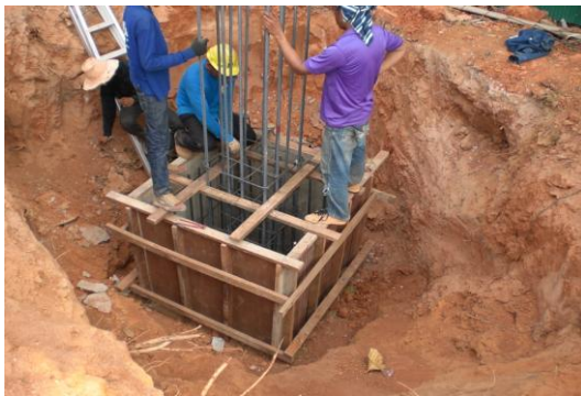
๕) ตรวจสอบดูเครื่อก้ายัน การยึดโยงต้องมั่นคงแข็งแรง
