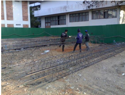
๓) ตรวจสอบการใส่โครงเหล็กเสริมคอนกรีตถูกต้องหรือไม่
