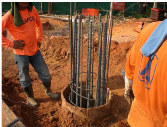
๔) ก่อนเทคอนกรีตต้องตรวจสอบความเรียบร้อยของกันหลุมด้วยแสงไฟ
