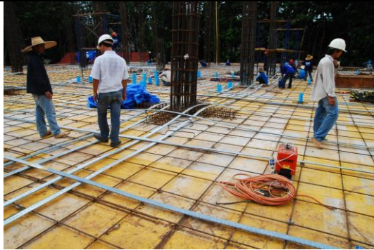
๖) ตรวจสอบและควบคุมการเทคอนกรีต
