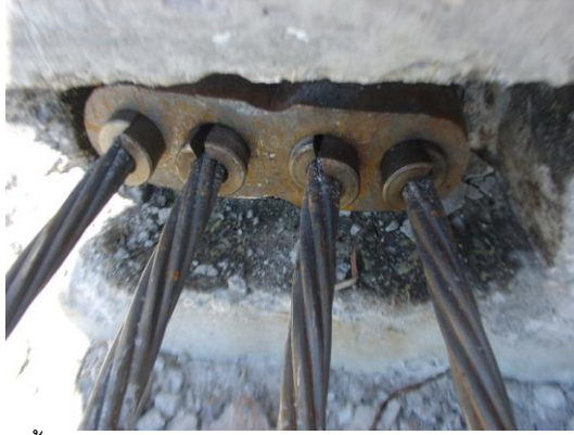
๙) ตรวจสอบขันตึงสายเหล็กเส้น และการยึด
