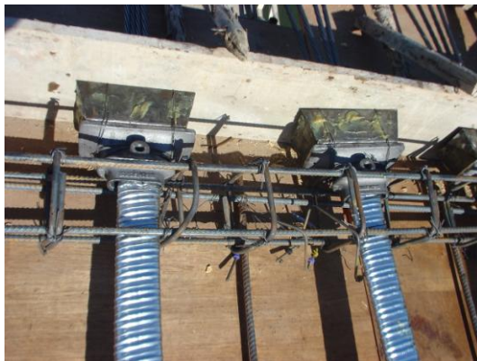
๓) ตรวจสอบการติดตั้งสมอยึด ( ANCHORAGE )
